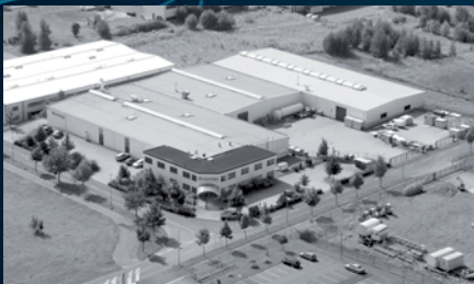
BOSECKER VERTEILERBAU SACHSEN GMBH, ZITTAU
